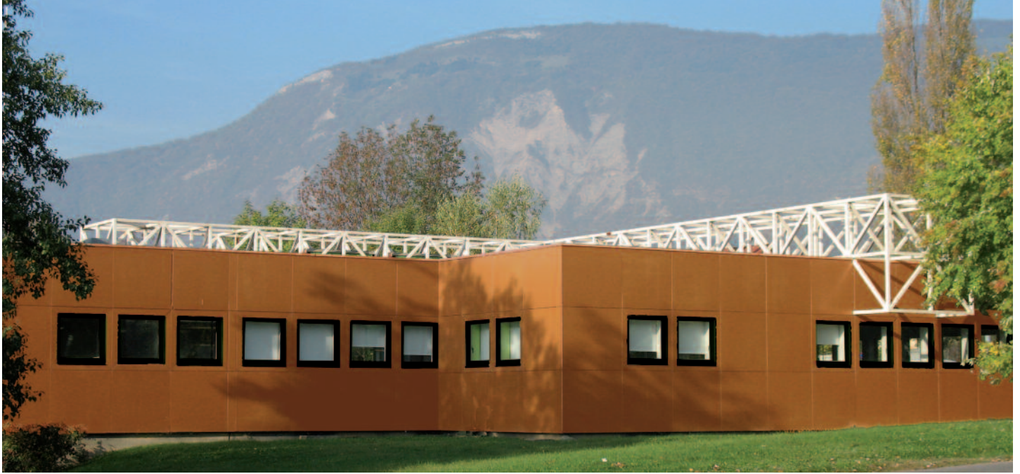
Rénovation calepinage des façades après désamiantage
